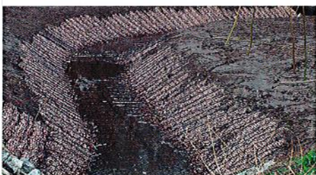
Steinmatten als Sicherungselement ...
