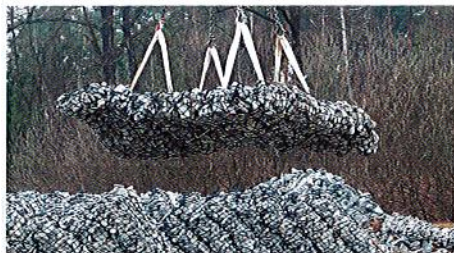
Steinmatten an Hebeschlaufen
